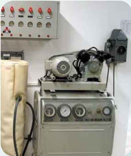
Druckluft - Erzeugung
